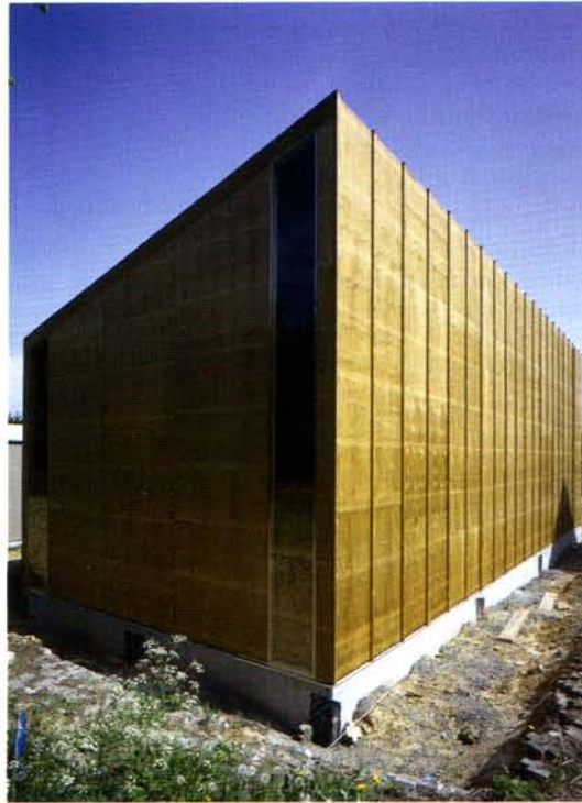
1 Ansicht der Salzlagerrhalle, Aachen © Jörg Hempel
