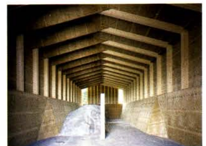
4 Innenansicht der Salzlagerhalle © Jörg Hempel
