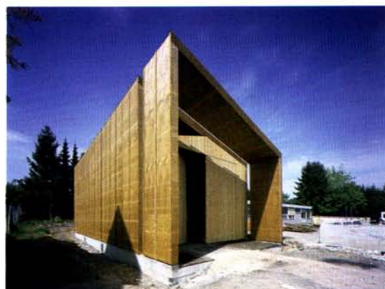
7 Ansicht Hallenrückseite © Jörg Hempel
