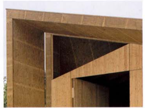
An der Eingangsseite zitiert der dreieckige Ausschnitt das statische Element des Dreigelenkbinders und sorgt für den notwendigen Lüftungsaustausch.
